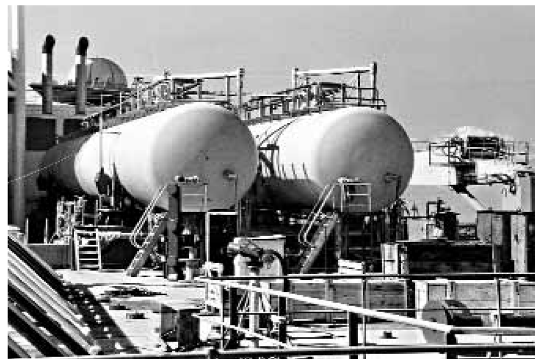
Система заправки жидким кислородом на Морском старте Sea Launch
